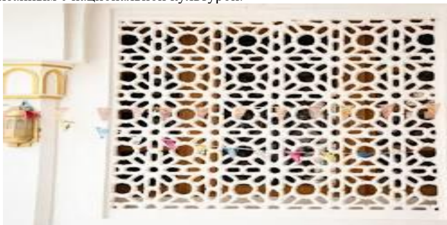
Рис. 4. Организация световой среды интерьера посредством перфорированных солнцезащитных экранов с национальным ритмическим раппортом
