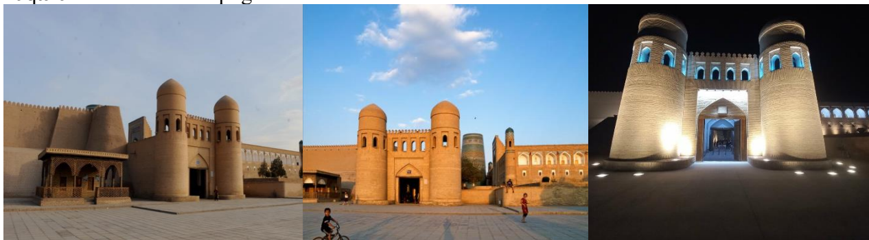
1-rasm.Ota darvozasining ko'rinishi
