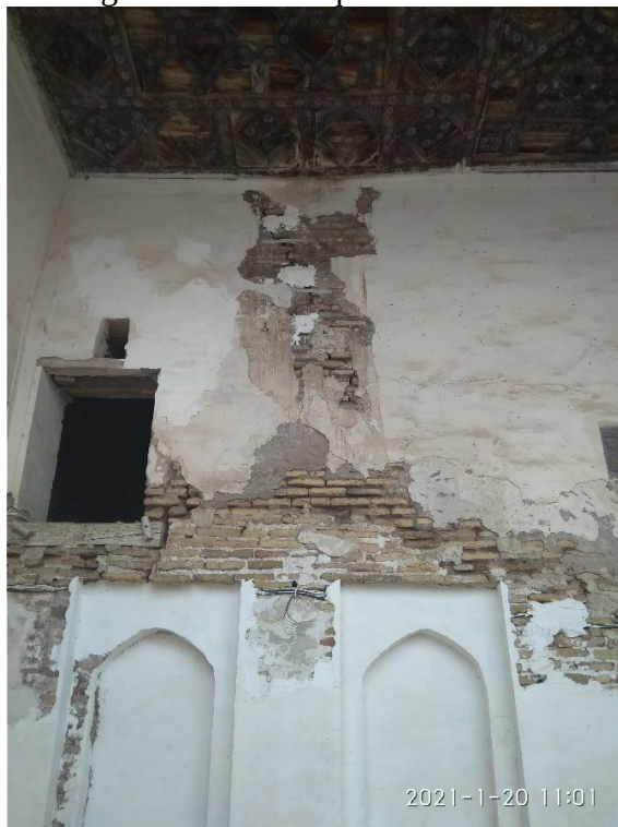
4-rasm. Masjid ayvonining buzilishi va Katta xona devorida paydo bo'lgan yoriqlarga soat tipidagi indikatorlar o'rnatildi
