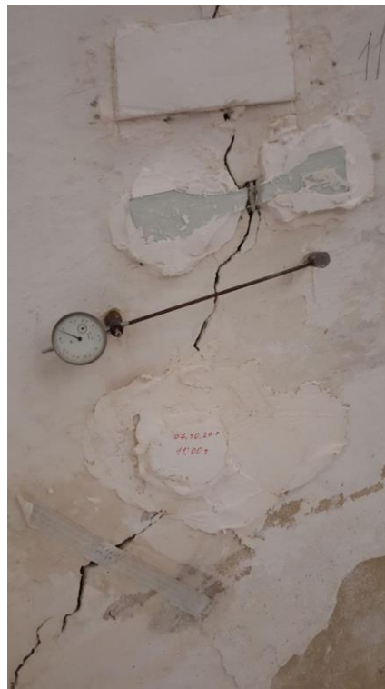
4-rasm. Masjid ayvonining buzilishi va Katta xona devorida paydo bo'lgan yoriqlarga soat tipidagi indikatorlar o'rnatildi
