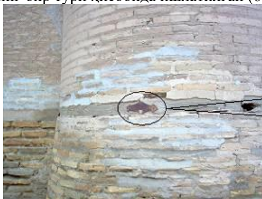
6-расм. Кутлуг Мурад Иноқ мадрасасидаги антисейсмик ёғоч бруслар ва маҳкамловчи метал элементлар (Ичан-Қалъа)
