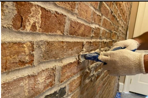
5-rasm. Kuchaytirilgan gorizontal choklarni qayta qorishma yordamida pardozlash
