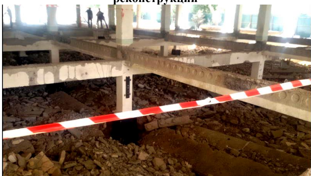
Фото №3. Общий вид конструкций перекрытия подвала здания библиотеки после демонтажа плит перекрытия подвала; на снимке видны колонны и ригеля каркаса серии ИИС 220 - 01
