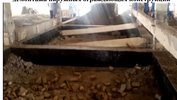
Фото №4. Общий вид конструкций перекрытия подвала здания после демонтажа плит и несущих ригелей перекрытия подвала, изготовления монолитных ж/б балок в плоскости колонн на 70 см ниже отметки существующего пола 1-этажа
