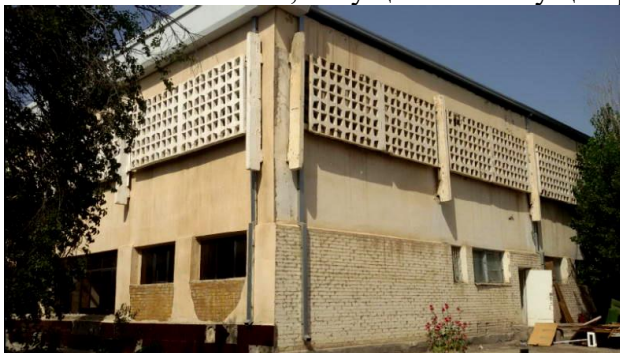
Фото №1. Общий вид здания библиотеки до реконструкции
