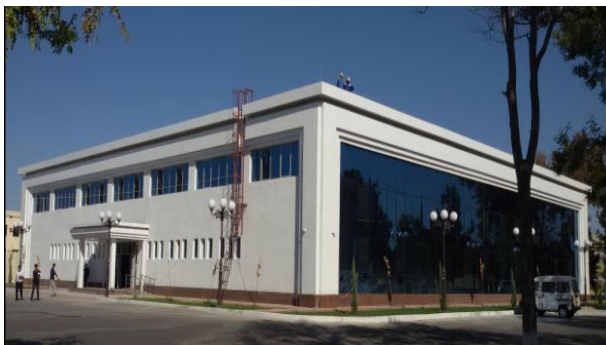
Фото №9а. Общий вид южного и восточного фасадов после завершения реконструкции объекта
