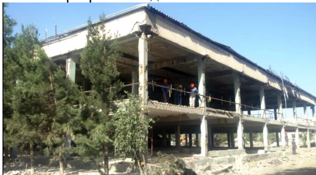
Фото №2. Общий вид здания библиотеки после демонтажа наружных ограждающих конструкций
