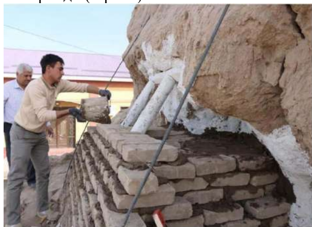
2-расм. Дешон Қалъа деворини таъмирлаш ишлари, сомон лой тайёрлаш жараёни
