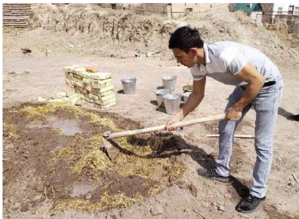
2-расм. Дешон Қалъа деворини таъмирлаш ишлари, сомон лой тайёрлаш жараёни
