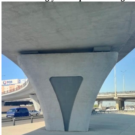
2.13-rasm. Temir-beton piyodalar estakadalarining bitta ustunli tayanch devorlari, Toshkent
