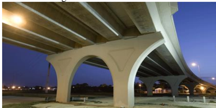
2.1-rasm AQShda transport yo'l o'tkazgichini oldindan zo'riqtirilgan tayanchi
