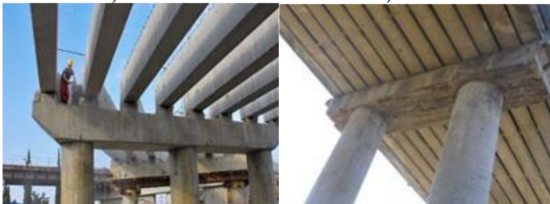
2.8-rasm.Birlashtiruvchi to'sin hamda ikkitalik va uchtalik tayanchlar
