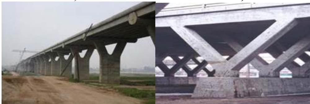
2.6-rasm. V-shakldagi ramka tayanchlari: ko'ndalang (a) va uzunlamasiga yo'nalishda (b)
