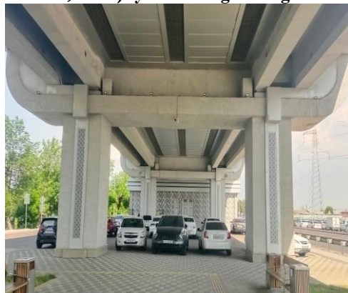
2.11-rasm. Temir-beton estakadalarning to'rtburchak ko'ndalang kesimli juft tayanchlari, Toshkent
