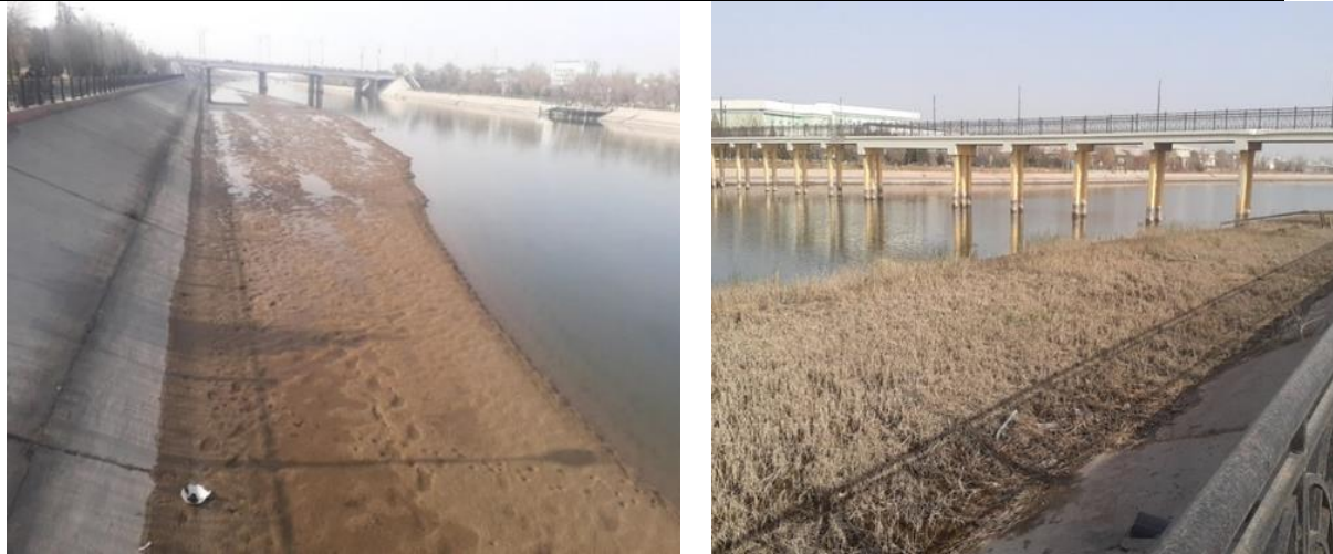
1-расм. Шовот каналининг Урганч шаҳрини кесиб ўтувчи қисмида оқим бўйича лойқа чўкиндиляри йиғилган ҳолати
