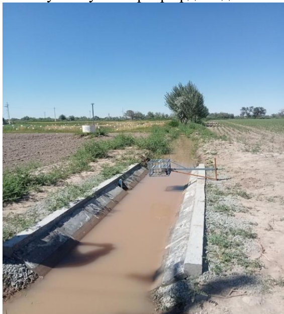
4-расм. “НИЦ 4000” номли электрон ускунанинг ўрнатиш жараёни.
