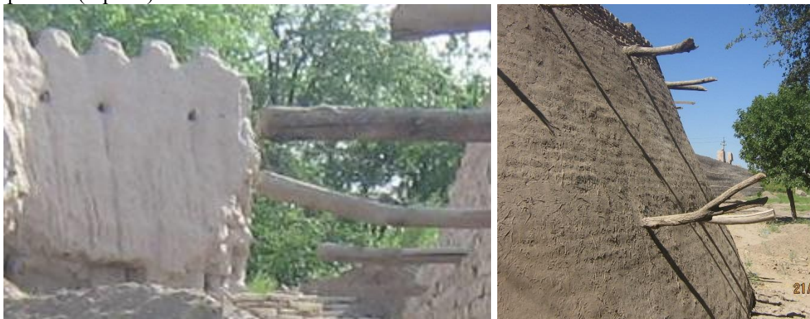
3-расм. Дешон-Қалъа ёдгорлигининг деворида ёғочларнинг ишлатилиши
