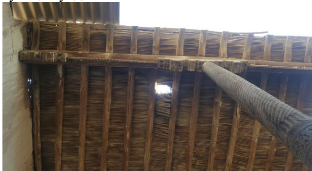
3-расм. Анъанавий уйнинг айвонидаги ёғоч устунни ва шип қисми
