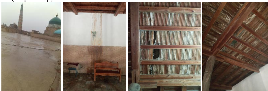
4- расм. Ёмғирнинг бино ичига ўтиши ва намликдан чириган шифт
