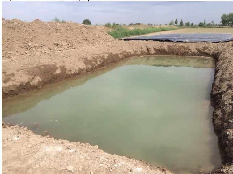
Рисунок 2. Участок, выкопанный для резервуара
