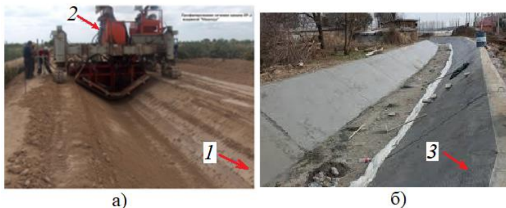
2 - расм. Канал ўзанини бетонлашга тайёрлаш:
