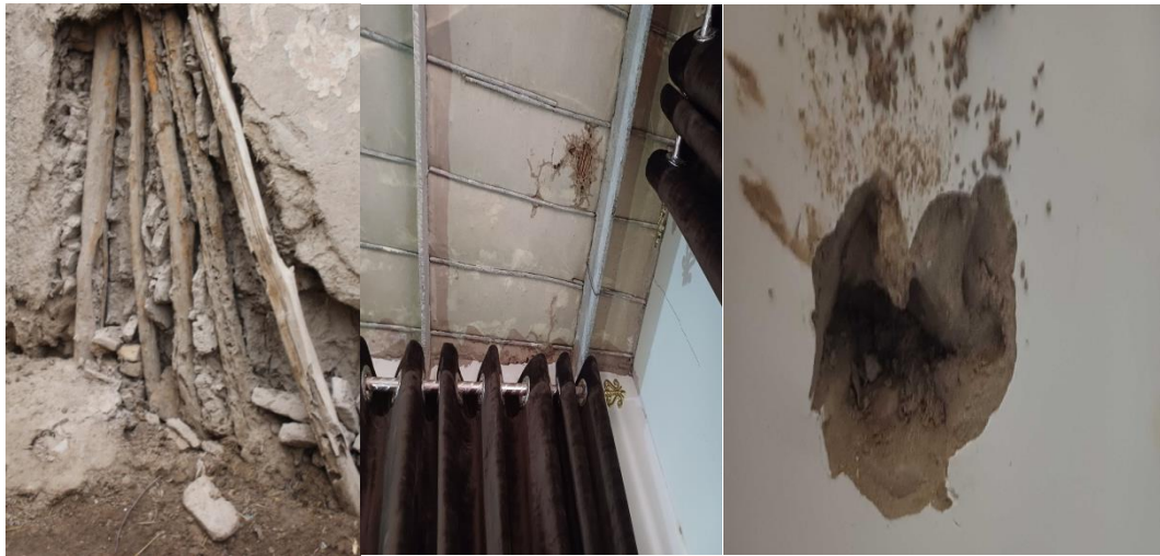
3.1.3-rasm. Turar joy binolardagi termit kamerasi va zarari (orginal rasmlar).
